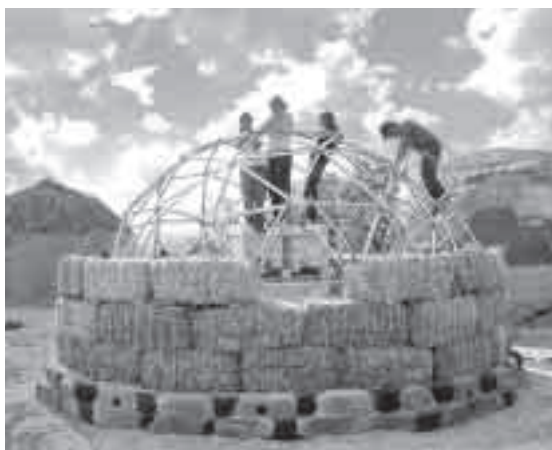
Costruzione di cupole con balle di paglia rivestite di terra su strutture geodetiche adibite ad alloggi per studenti del Center for Creative Ecology del Kibbutz Lotan in Israele (Kibbutz Lotan).
